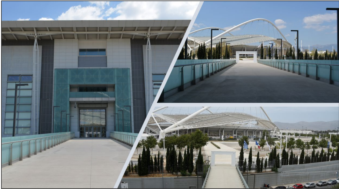
Εικόνα 2: Γέφυρα που ενώνει το Ενιαίο Εμπορικό & Επιχειρηματικό Συγκρότημα Golden Hall με το ΟΑΚΑ, μετά την επέκταση του 2019
