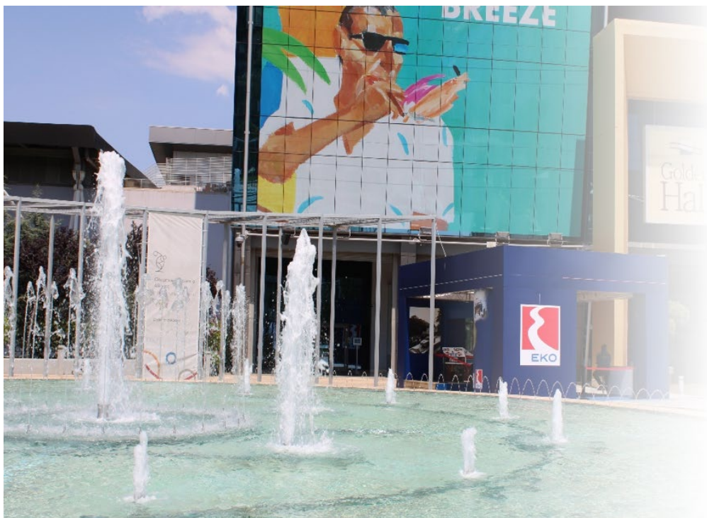
Εικόνα 8: Σύστημα καθαρισμού και ανακύκλωσης της τεχνητής λίμνης στο χώρο του Ενιαίου Εμπορικού & Επιχειρηματικού Συγκροτήματος Golden Hall
